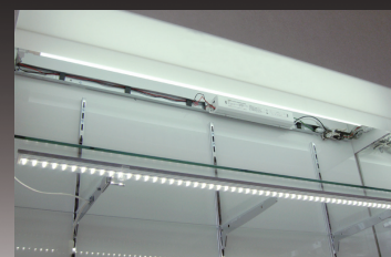
F型 施工例
